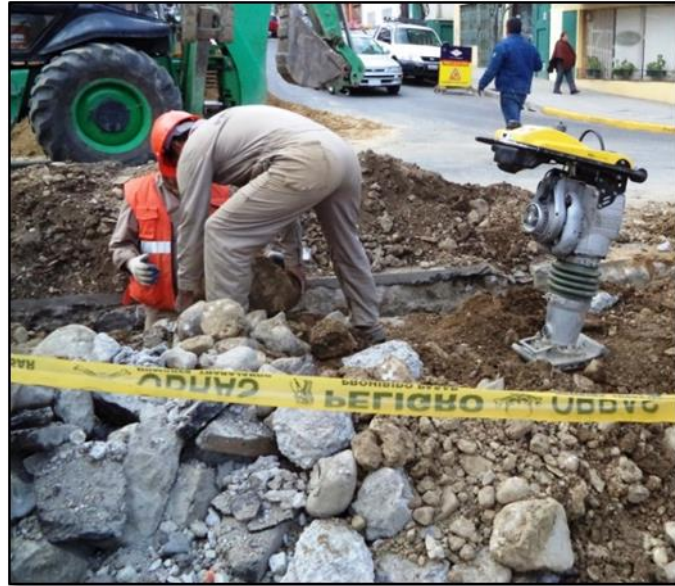
Generación de Escombros
