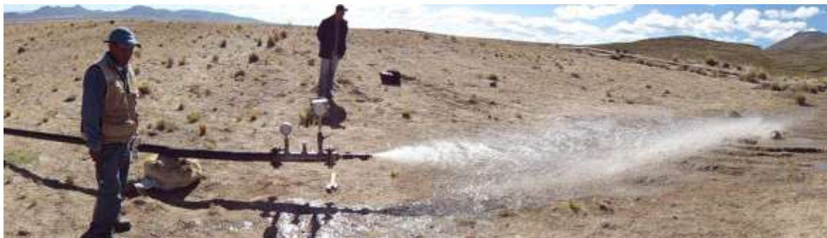
Descarga de agua en prueba hidráulica
