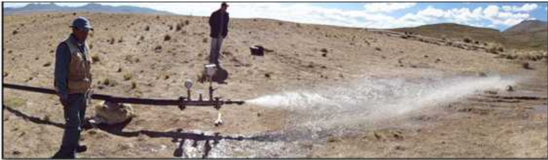
Descarga de agua en prueba hidráulica
