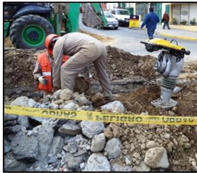
Generación de Escombros
