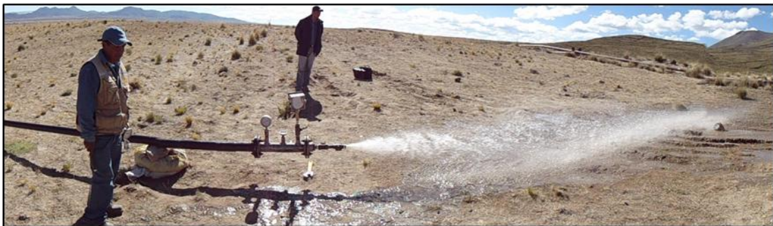
Descarga de agua en prueba hidráulica
