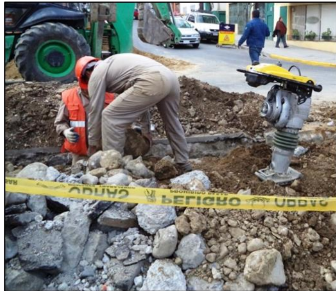
Generación de Escombros
