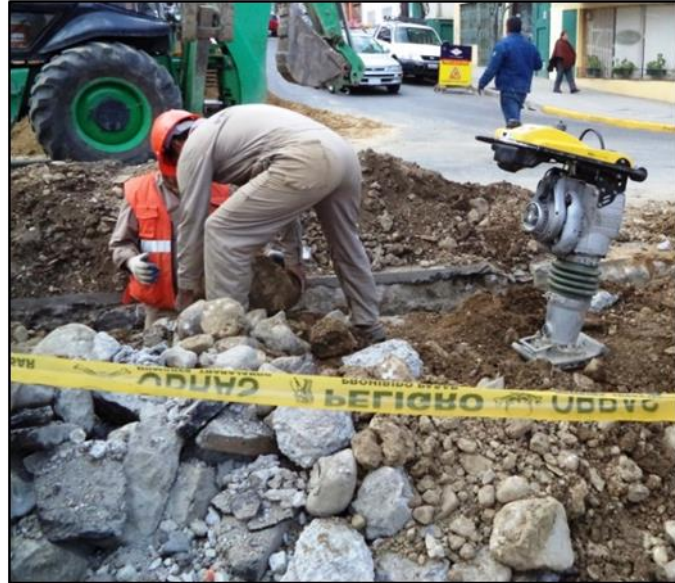
Generación de Escombros
