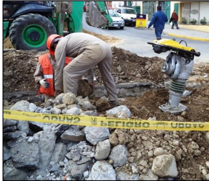
Generación de Escombros
