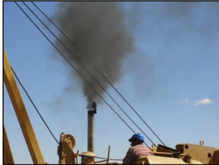
Emisión de gases de combustión
