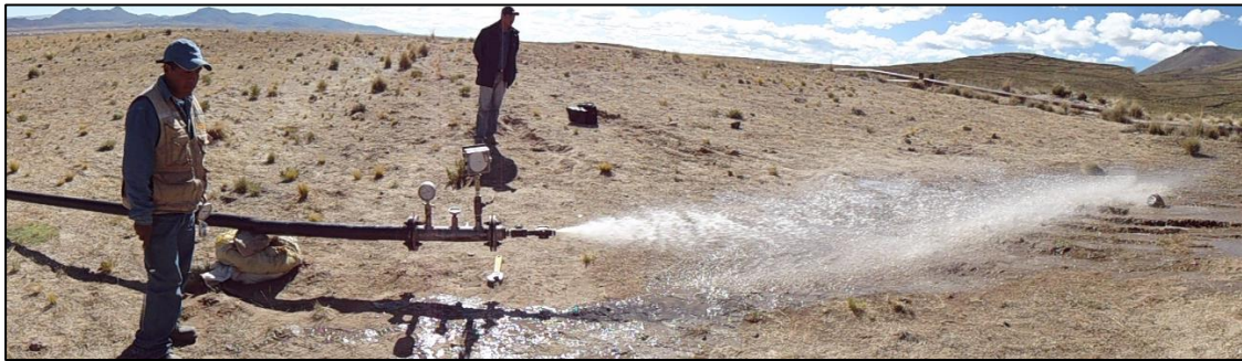
Descarga de agua en prueba hidráulica
