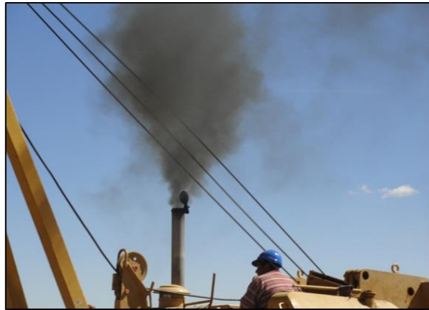
Emisión de gases de combustión
