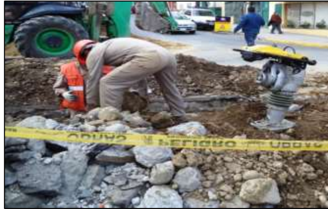
Generación de Escombros
