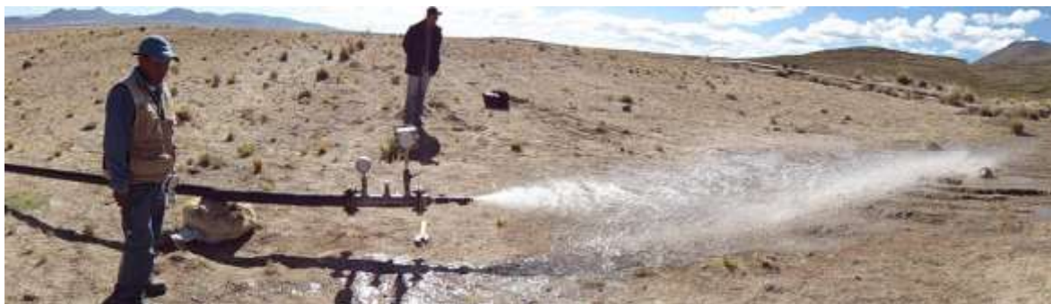
Descarga de agua en prueba hidráulica
