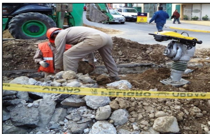
Generación de Escombros
