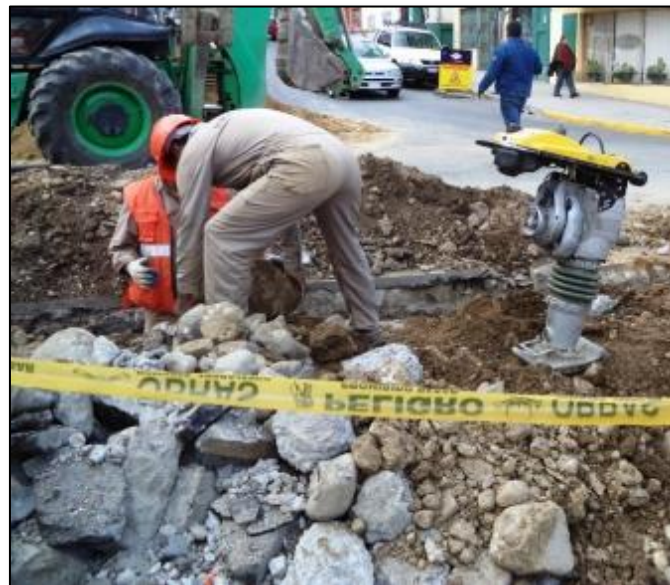
Generación de Escombros
