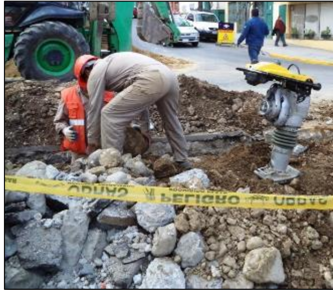
Generación de Escombros
