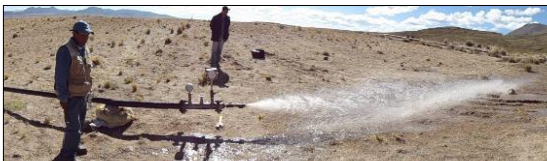
Descarga de agua en prueba hidráulica
