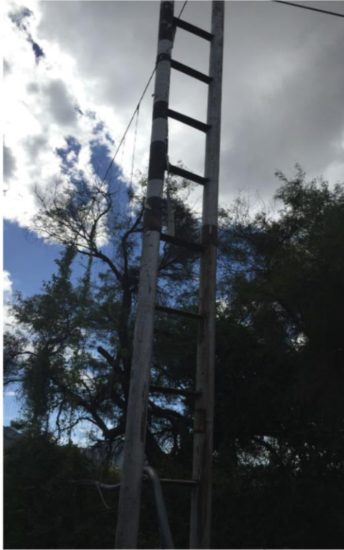
ESTRUCTURA 1 LIMPIEZA Y PINTADO
