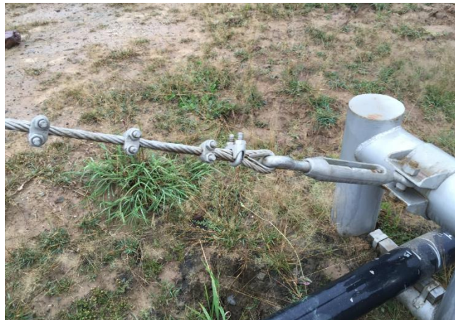
DETALLE DE ANCLAJE A PUNTO MUERTO
