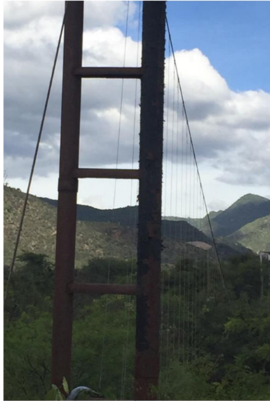
POSICIONADO PARALELO A LA TUBERIA DE AGUA
