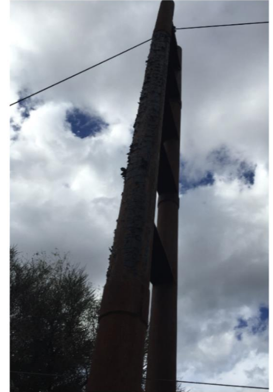
ESTRUCTURA 2 LIMPIEZA Y PINTADO
