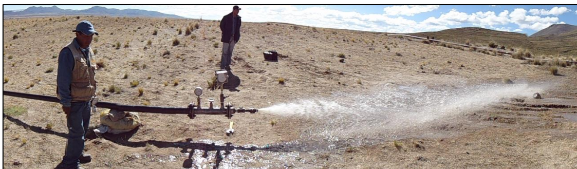
Descarga de agua en prueba hidráulica
