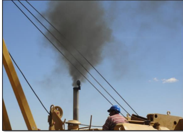
Emisión de gases de combustión
