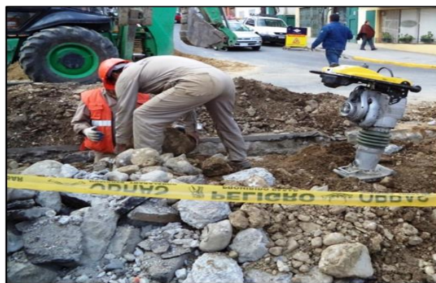
Generación de Escombros
