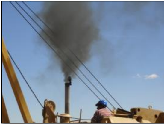
Emisión de gases de combustión
