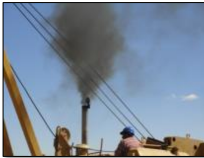
Emisión de gases de combustión
