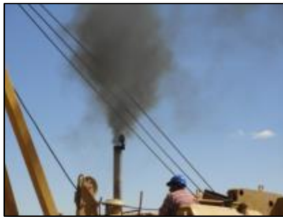
Emisión de gases de combustión
