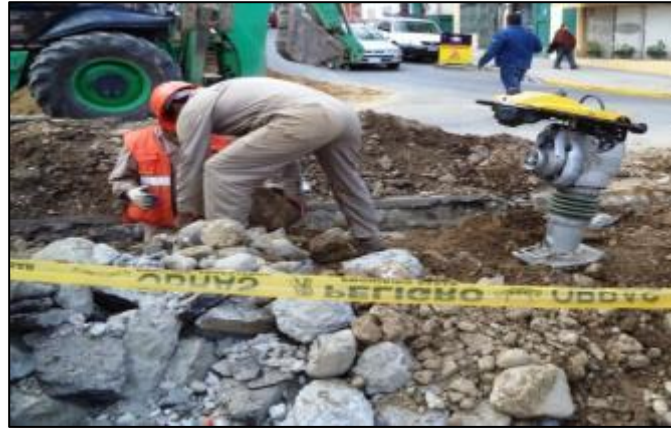
Generación de Escombros
