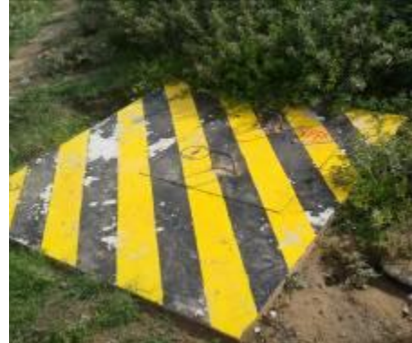
ADECUACION DE CAMARA CON TAPA DE 0,60 x 0,60 m.
