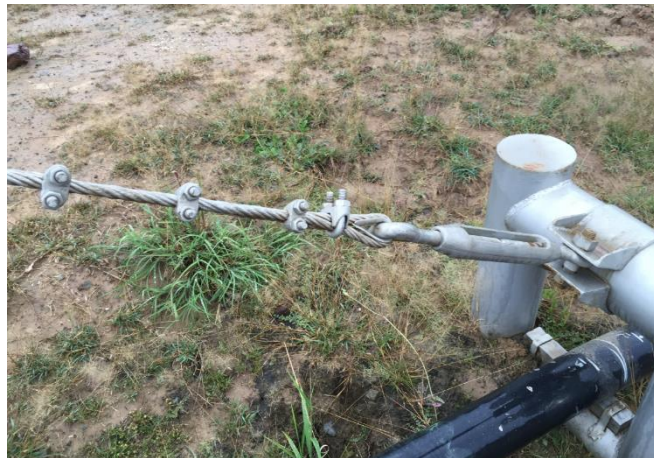
DETALLE DE ANCLAJE A PUNTO MUERTO
