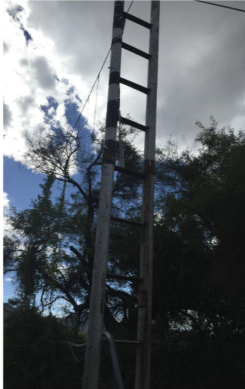
ESTRUCTURA 1 LIMPIEZA Y PINTADO
