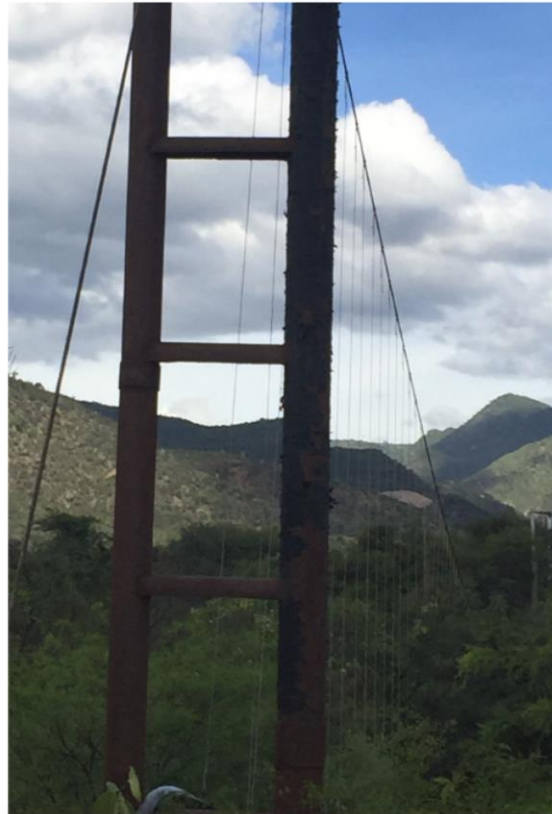
POSICIONADO PARALELO A LA TUBERIA DE AGUA
