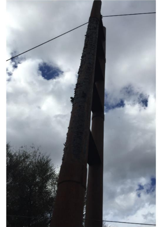
ESTRUCTURA 2 LIMPIEZA Y PINTADO
