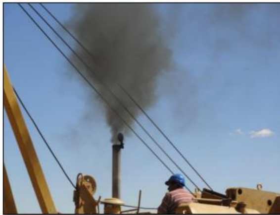
EMISIÓN DE GASES DE COMBUSTIÓN
