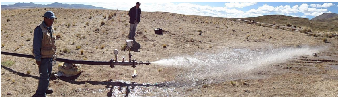
Descarga de agua en prueba hidráulica
