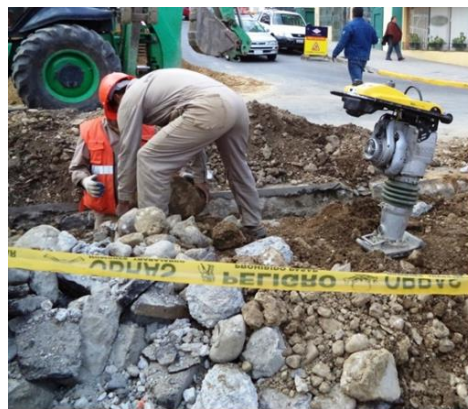
Generación de Escombros
