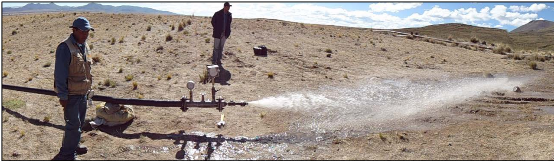
Descarga de agua en prueba hidráulica
