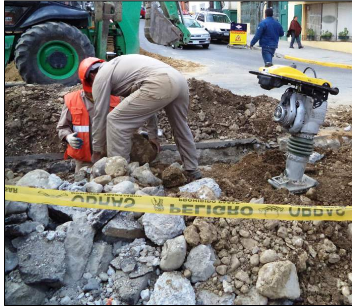
Generación de Escombros
