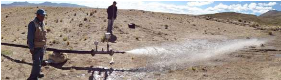
Descarga de agua en prueba hidráulica
