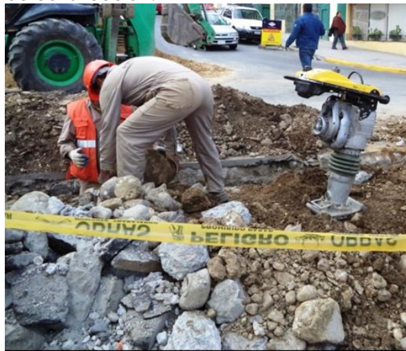
Generación de Escombros
