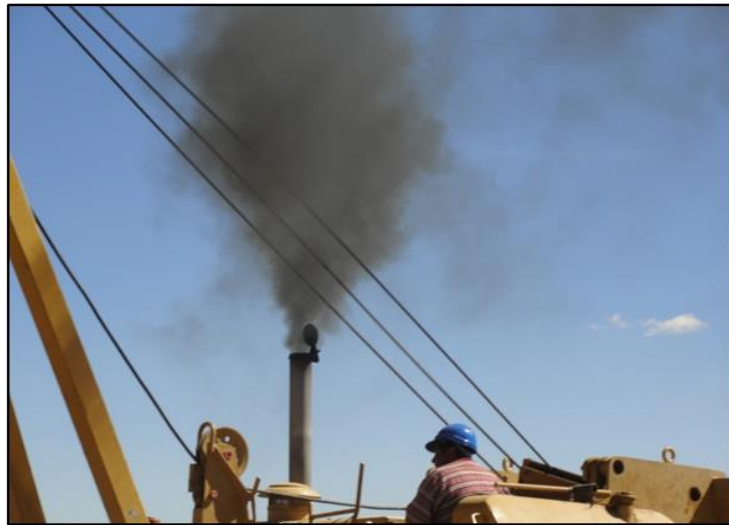
Emisión de gases de combustión
