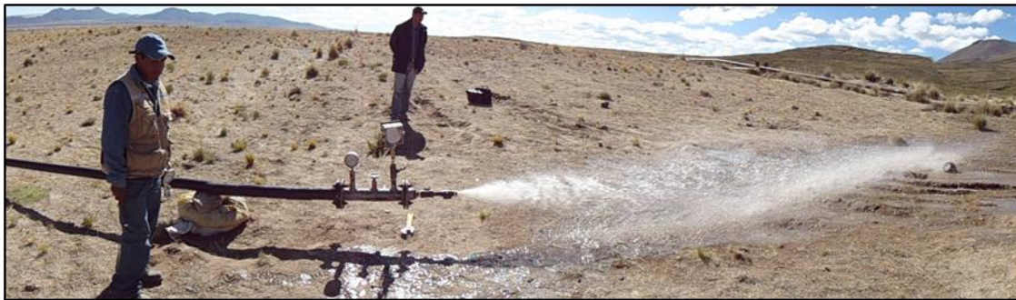
Descarga de agua en prueba hidráulica
