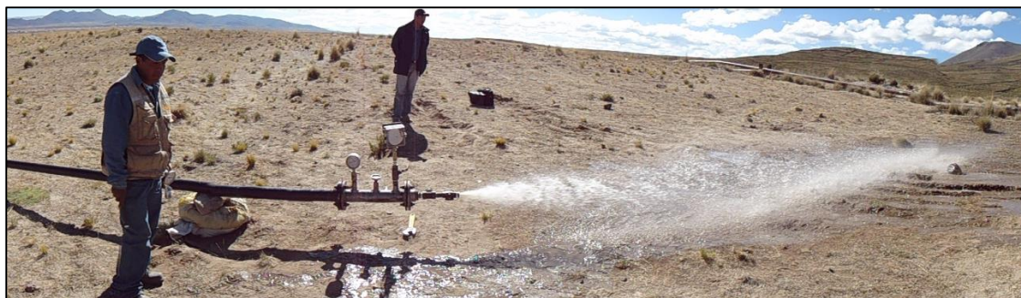
Descarga de agua en prueba hidráulica
