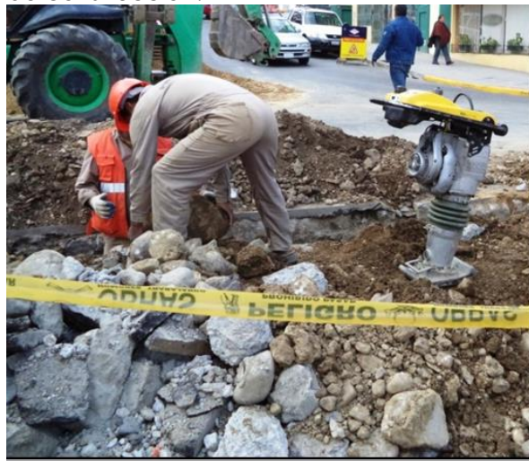
Generación de Escombros
