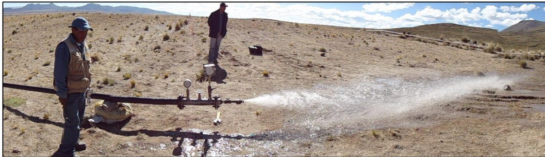
Descarga de agua en prueba hidráulica
