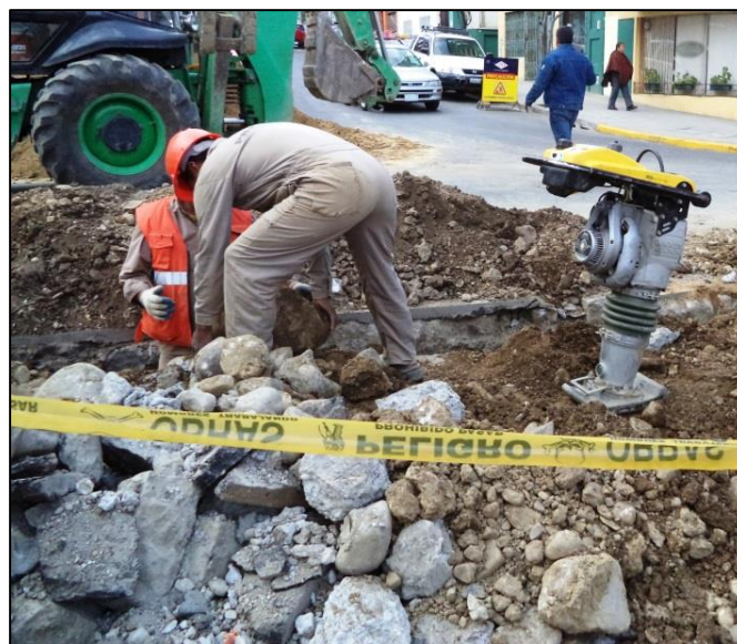
Generación de Escombros
