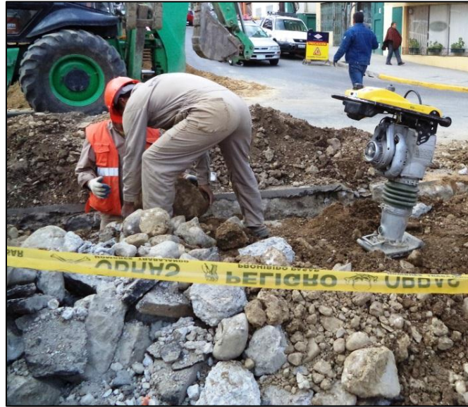
Generación de Escombros
