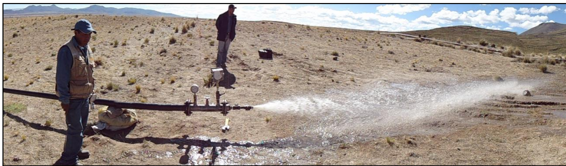
Descarga de agua en prueba hidráulica
