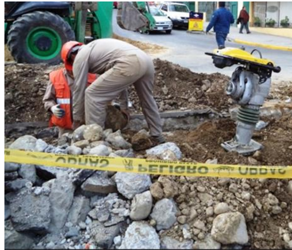
Generación de Escombros
