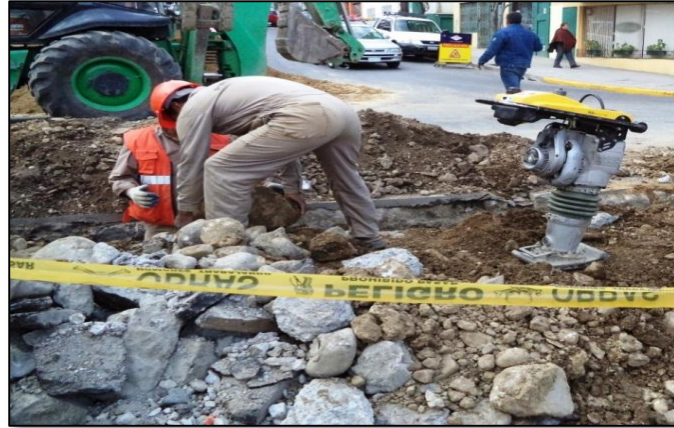
Generación de Escombros
