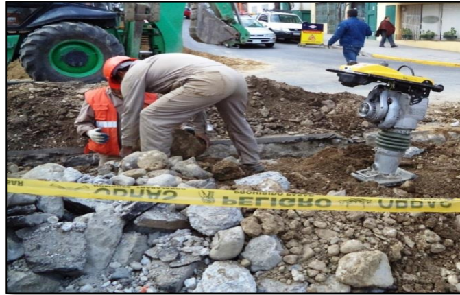
Generación de Escombros
