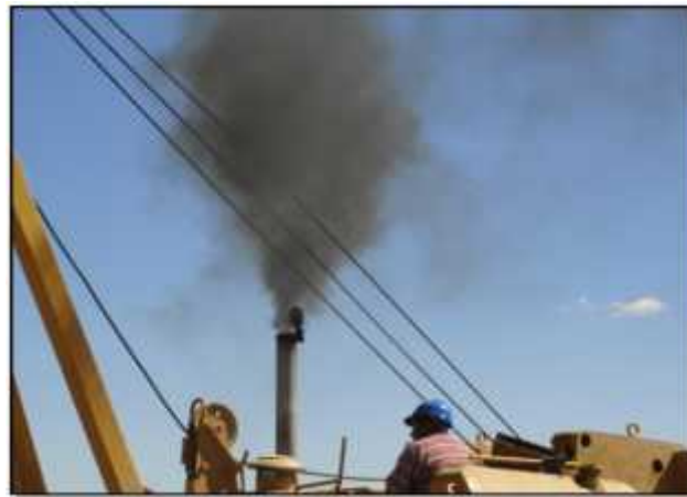
Emisión de gases de combustión
