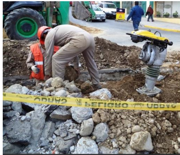
Generación de Escombros
