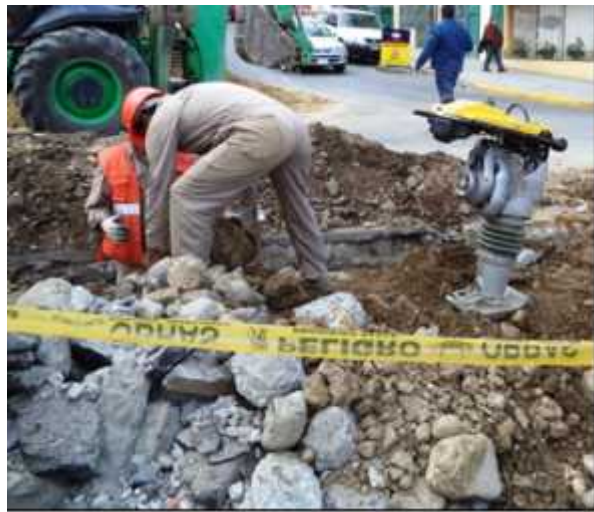
Generación de Escombros
