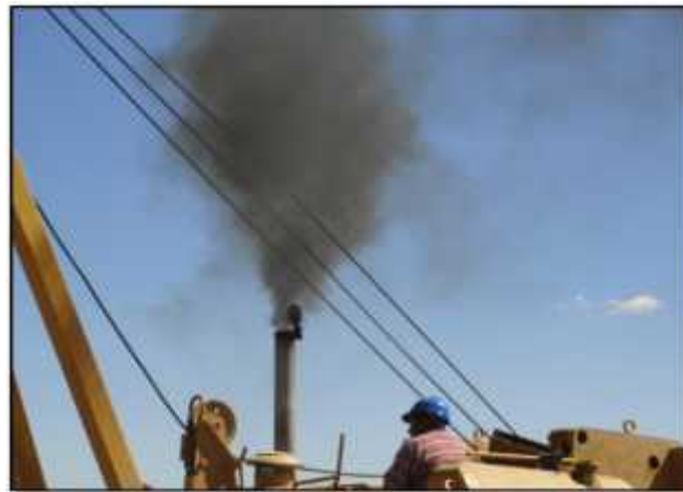
Emisión de gases de combustión
