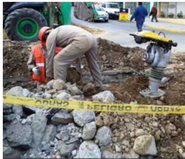
Generación de Escombros
