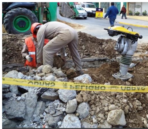
Generación de Escombros
