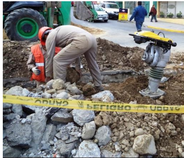
Generación de Escombros
