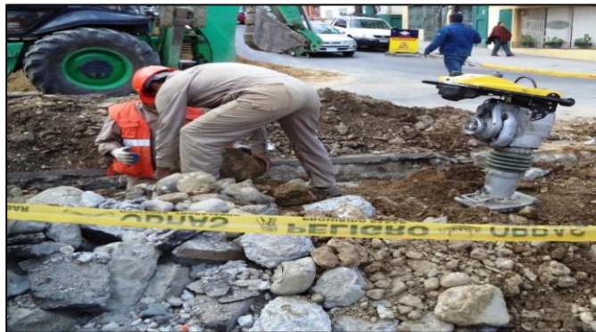
Generación de Escombros
