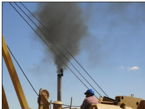
Emisión de gases de combustión
