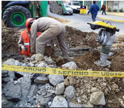
Generación de Escombros
