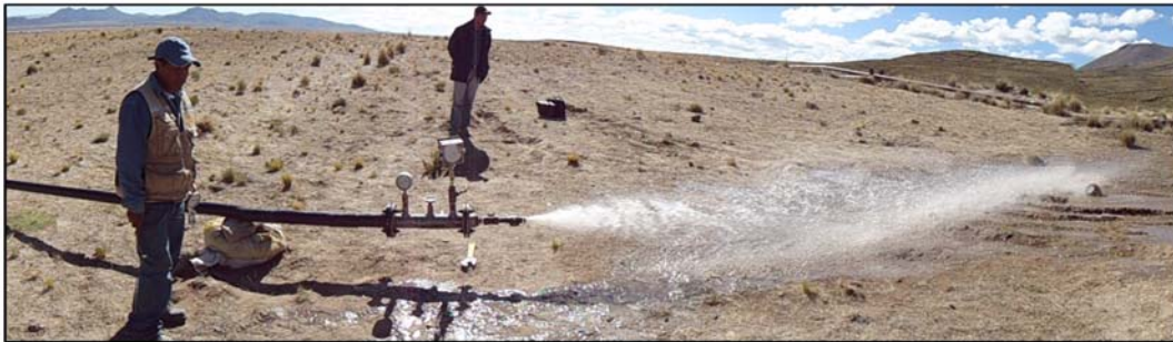
Descarga de agua en prueba hidráulica
