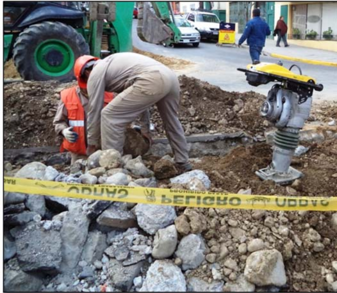
Generación de Escombros
