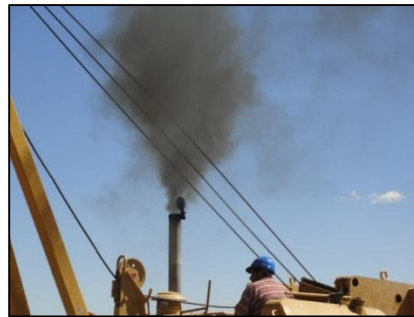
Emisión de gases de combustión
